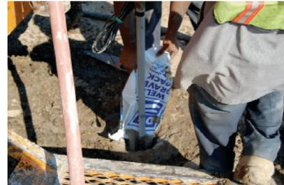
3. Entourez le géophone en sondage et le câble de gravier.
